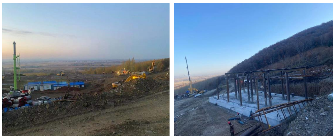
项目现场照片
